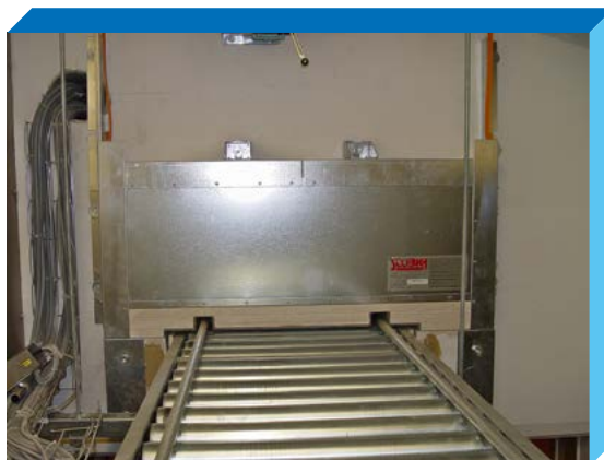
► Tenda a movimentazione orizzontale con la trazione a cavi.
